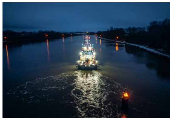
Van Oord fährt auch in Wasserstraßen große Gerätschaften auf, hier für eine Wasserinjektionsbaggerung
