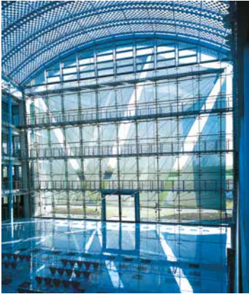
Eine FESTO Gebäudeversattung
