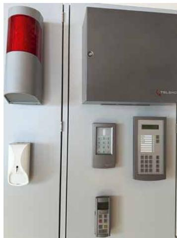
Sprachalarmierungsanlage als Bestandteil einer Brandmeldeanlage
