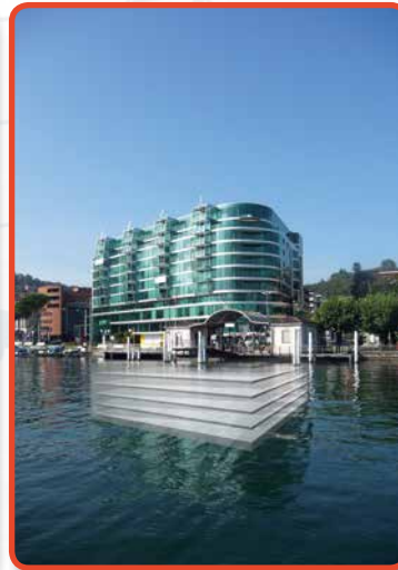
Trocken bis ins fünfte Untergeschoss: Parkhaus Palazzo Mantegazza in Lugano
