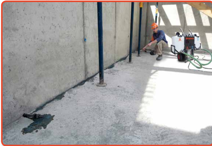
Fachmann bei der Arbeit: Verpressen der Dryset-Profile an Boden und Wand
