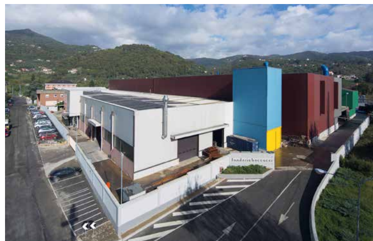
Gute Lage: Die Produktion befindet sich in der Nähe des Hafens von La Spezia
