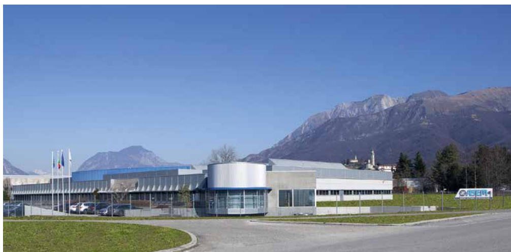
Die Firmenzentrale in Artegna: Die gesamte Hardware wird in Italien entwickelt und produziert
