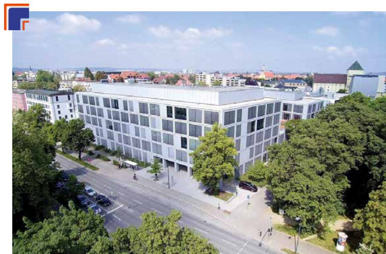
Ein Großprojekt: Für den Neubau der Berufsschule 1 in Landshut übernahm die Ludwig Rieder GmbH sämtliche Gebäudeinstallationsarbeiten
