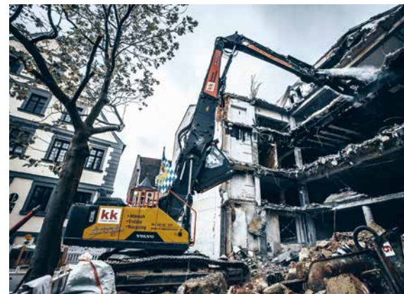
Konrad Kreppold sorgt für die Entsorgung der Materialien, auch kontaminierter Stoffe
