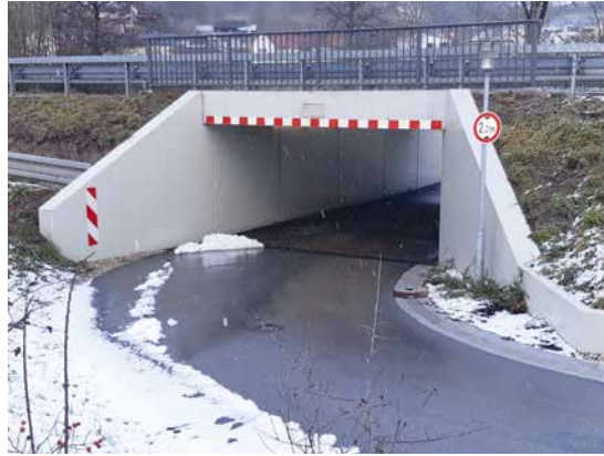
Für die Fahrradfahrer-Unterführung an der B 303 in Coburg-Ahorn hat FUCHS alle Leistungen übernommen, mit Ausnahme der Asphaltherstellung
