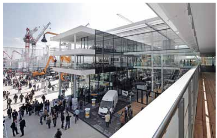
13,5 m hoch und in sechs Monaten aufgebaut: Der temporäre Außenpavillon für Liebherr wird alle drei Jahre auf der Bauma München neu errichtet
