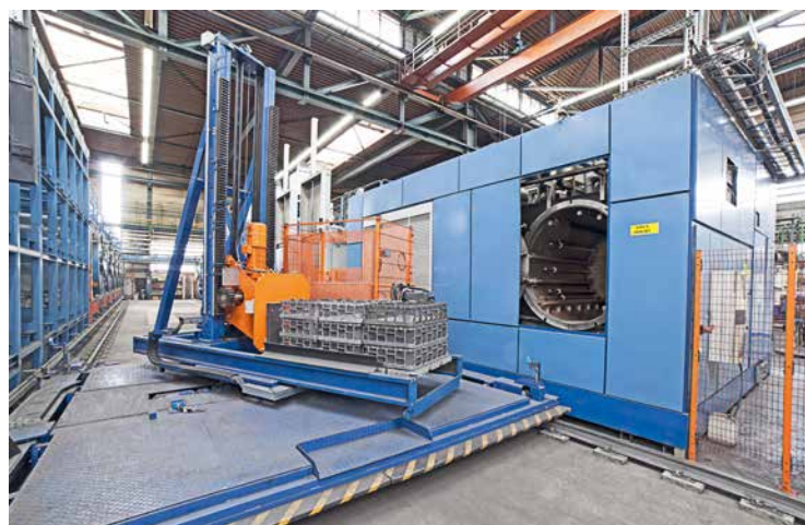
Eine Hybrid-Reinigungsanlage vor der Wärmebehandlung
