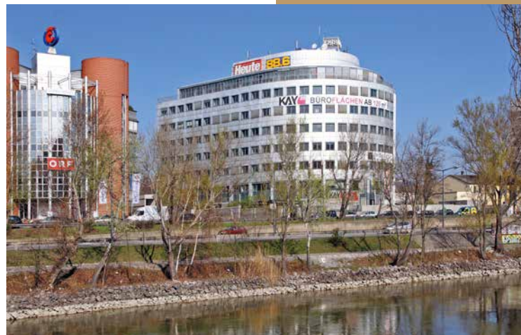
Direkt an der Donau liegt das Bürogebäude 'KAY29'. Auf 150 m 2 haben sich hier vor allem kleine und mittelständische Unternehmen angesiedelt
