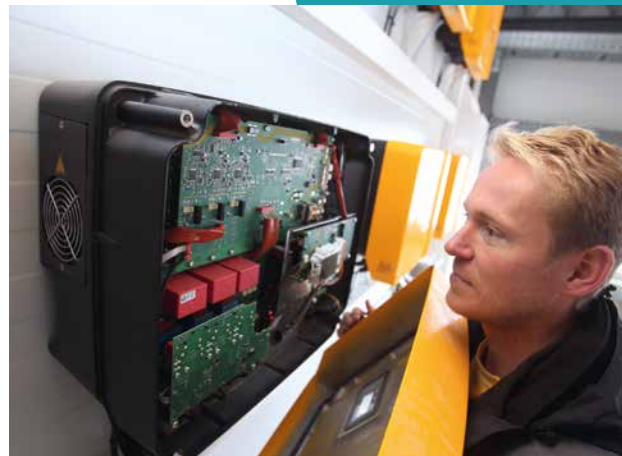
Elektrotechnik ist einer der hauptsächlichen Geschäftsbereiche im breiten Portfolio des Unternehmens
