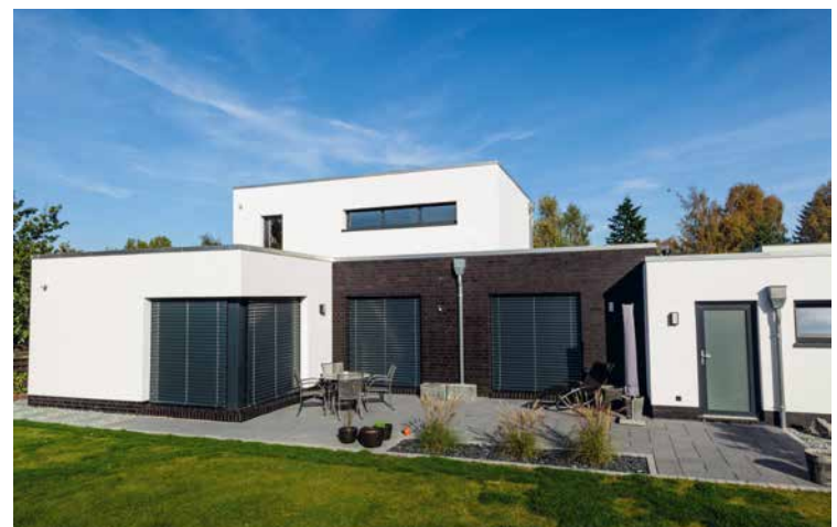
Alles aus einer Hand: Tönjes & Meichsner baut schlüsselfertig
