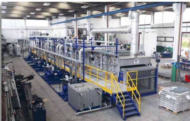
Pulizia per la verniciatura: qui vengono puliti i contenitori di alluminio
