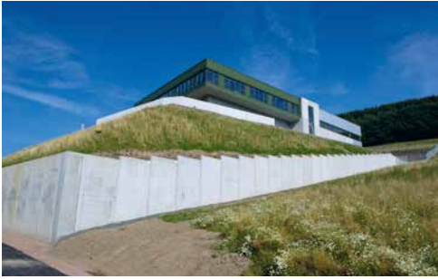
Bosch Beton-Stützwände sind vorgefertigt und lassen sich auf der Baustelle schnell errichten.
