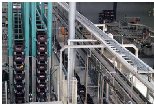
Die Systeme des Unternehmens werden auch in großen Produktionen eingesetzt, hier in Westmalle
