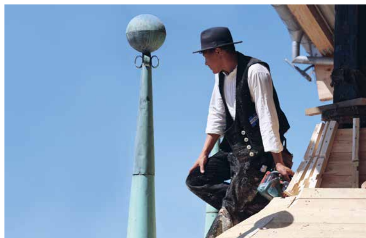
Eines von vielen Gewerken: Zimmerarbeiten an den Juliüstürmen am Rathaus Hannover
