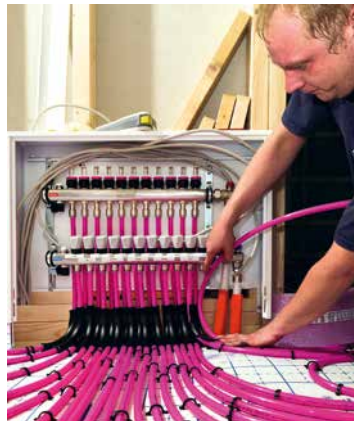
Robust und sicher: das EQtec 5-Sicherheitsrohr mit innenliegender EVOH-Sperrschicht, verlegt durch EQ Planung + Montage
