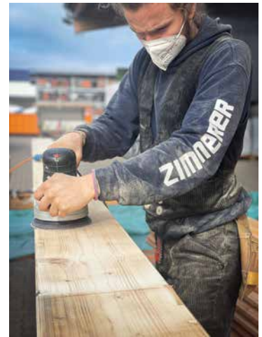
Echte Handarbeit: Zimmermann beim Schleifen eines Holzbalkens
