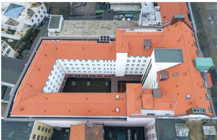
Neubau eines Steildachs: Motel One
