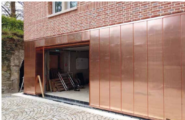
Bauklempnerei: Kupferfassade am Neubau von Schloss Landestrost in Neustadt
