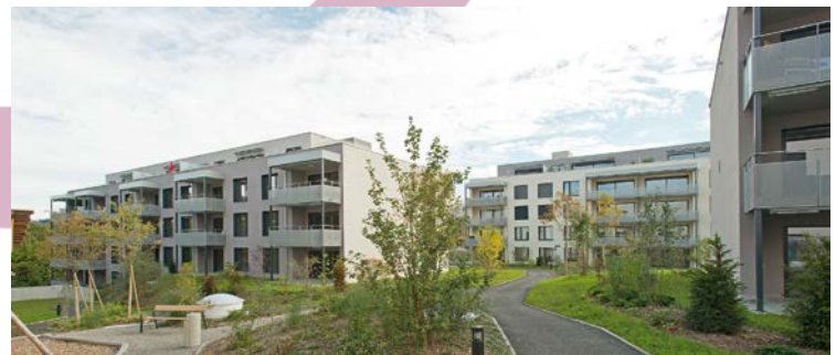
Die 'Engelwiese' ist eine Wohnsiedlung in St. Gallen, die von der Fortimo AG entwickelt und realisiert wurde
