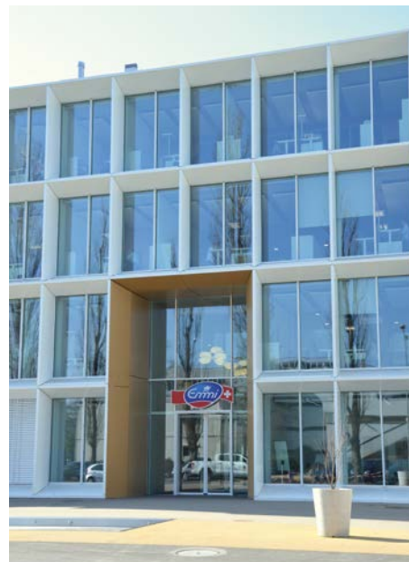
Die Eingangstür, Teil der Fassade der Butterzentrale Emmi in Luzern
