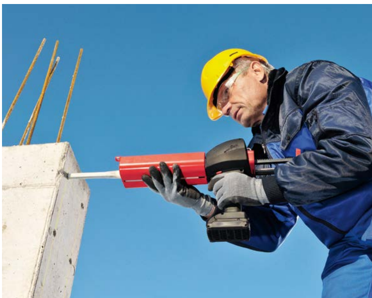
Sparte Industrial: 'Chemischer Dübel' im Brückenbau
