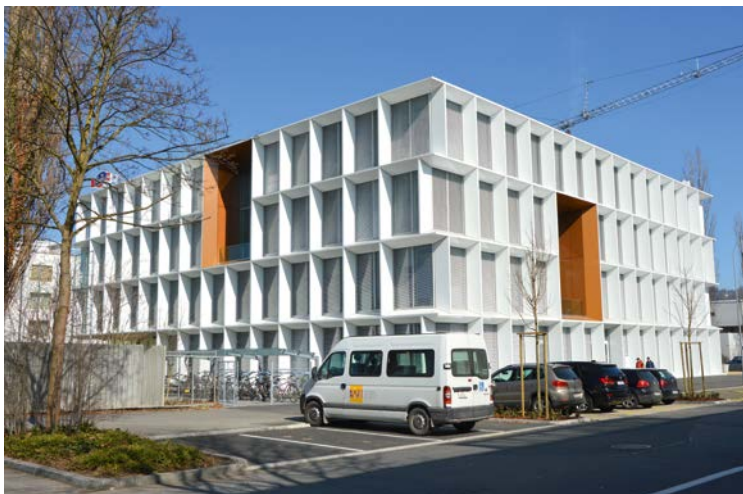
Beispiel Fassadenbau, Pfosten-Riegel-Elementbau für die Fassade der Butterzentrale Emmi in Luzern
